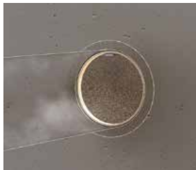
Wenn die Temperatur im Kanal 72 °C erreicht, schmilzt das Schmelzlot und beide Teile des Klappenblatts schließen sich.
