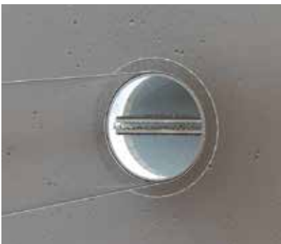
Das Brandschutzelement wird in einem Lüftungsrohr aus Metall mit dem gleichen Durchmesser und mit einer Gummidichtung eingesetzt.
