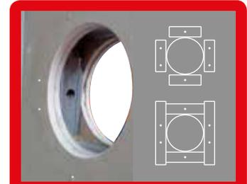
En paroi légère, il n'est pas nécessaire de prévoir de chevêtres à priori : forez la réservation après montage de la cloison et insérez (ex post) 4 morceaux de profils métalliques à l'endroit où les vis de fixation du collier sont prévues. (Seulement pour parois symétriques)
