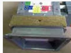
Pour calfeutrer un clapet CU-LT, glissez des bandes de laine de roche entre les parties métalliques saillantes sur le corps du clapet.
