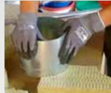
Dans un panneau de 5 cm, découpez 8 épaisseurs pour réaliser la profondeur de 40 cm.
