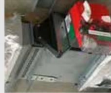
Dans un panneau de laine de roche 40 kg/m<sup>3</sup>, épaisseur 5 cm, découpez un rectangle de largeur L x 40 cm. Positionnez ce rectangle sur le clapet de manière à ce qu'il soit centré sur le mur et plaquez le CCF contre la dalle pour obtenir 25 mm de laine comprimée.
